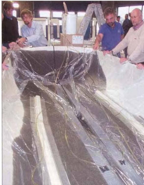
FIG. 1.7 – Procédé de transformation en moule fermé - Infusion.
